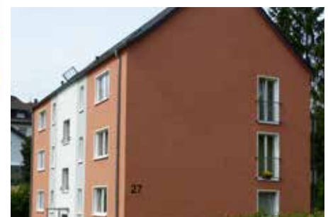
Energetisch modernisiert: Im Spieck 27
